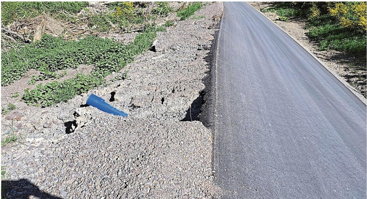
**Gerade saniert, schon wieder in Gefahr:** Der Asphalt auf der Kreisstraße 50 von Rhadern nach Fürstenberg ist zumindest an einer Stelle schon wieder unterspült, die Bankette nicht gescheit ausgeführt.
