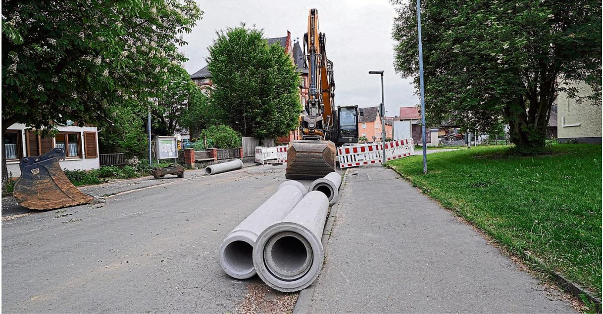
Aktuell wird der Mischwasserkanal verlegt, parallel dazu finden Wasserleitungsarbeiten statt.
